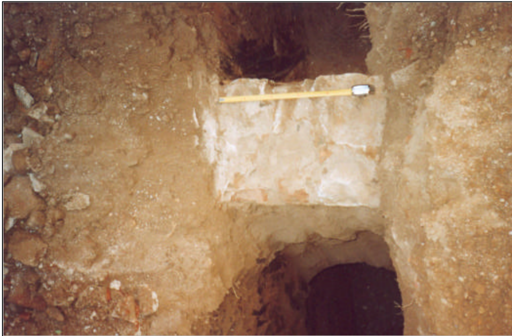
Foto 4.- Detall del mur U.E. 10 que funciona amb un dels pilars de formigó.
